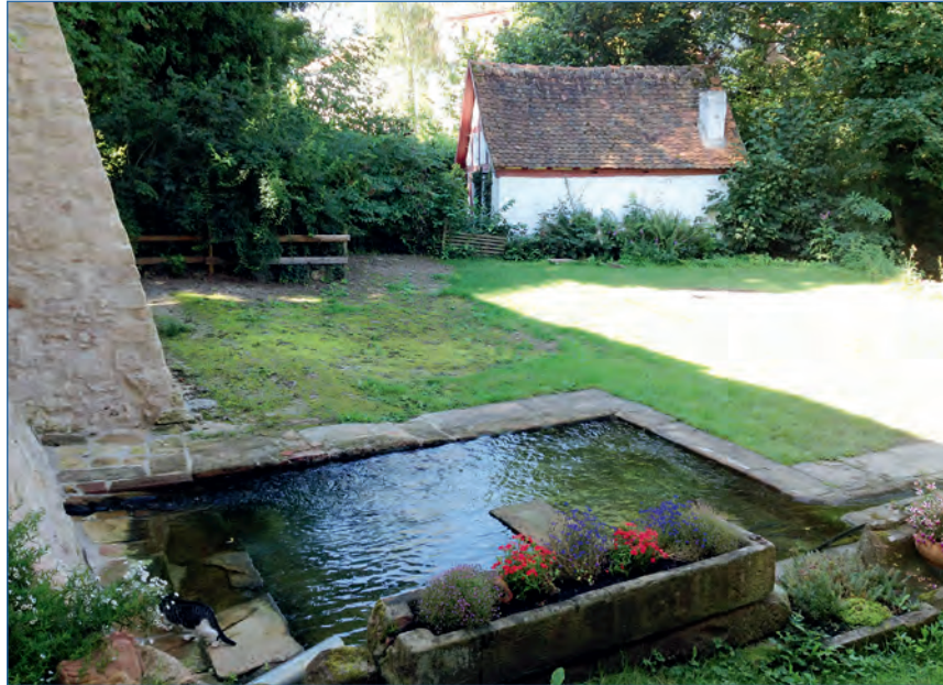
Wasserzulauf aus dem Stadtbrunnen durch die Stadtmauer und Waschplatz mit Ablauf in die Nidder, im Hintergrund die Mikwa
